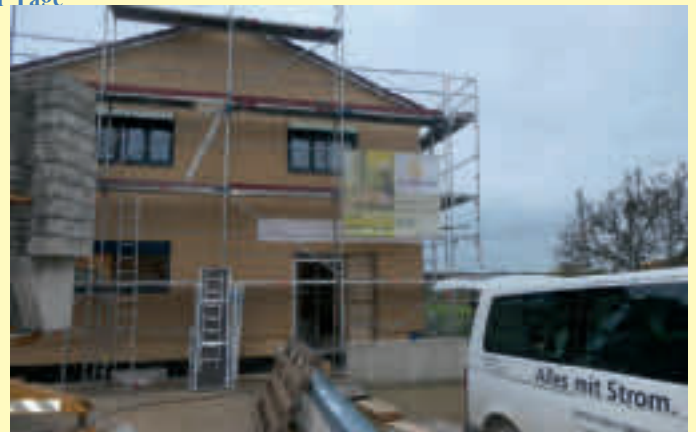
Die Familie Marx hat sich entschlossen, das zweistöckige Haus außen mit Holzfaserdämmplatten nach dem aktuellen Standard zu dämmen und es anschließend zu verputzen.
